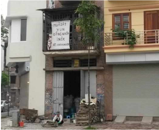
Type 1 : maison de bonne facture ou en construction
